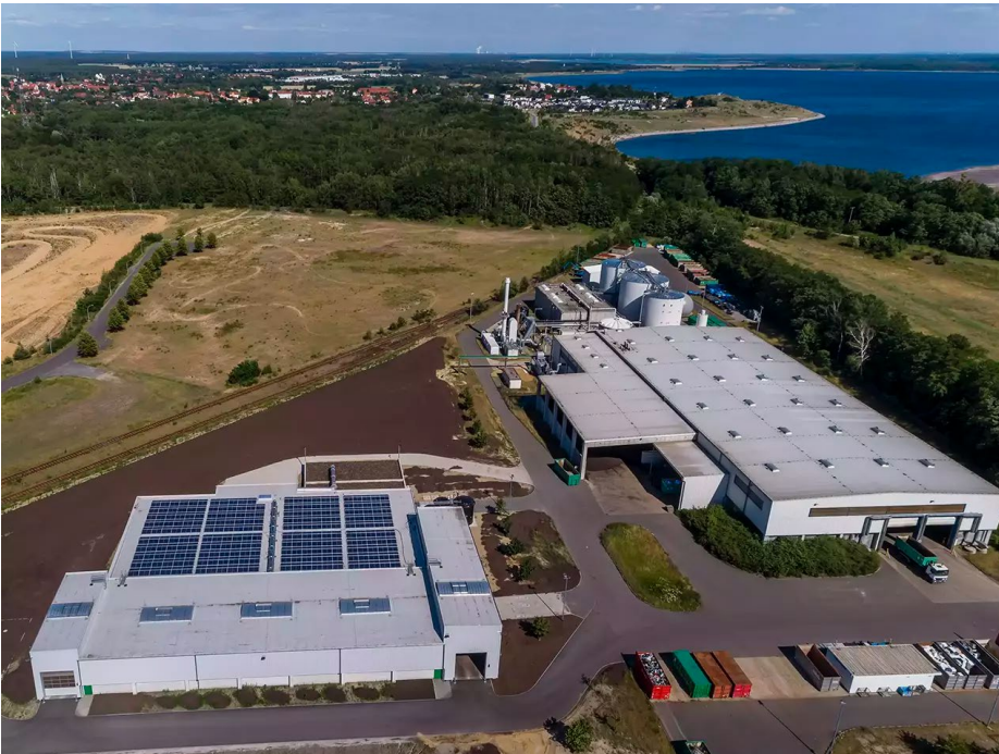
Im Bio-Energie-Zentrum in Freienhufen werden Bio- und Grünabfälle sowie Sperrmüll verwertet. Foto: AEV/ Rainer Weisflog
