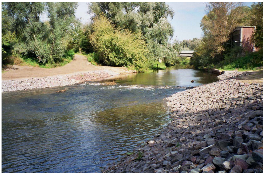
Wehr Zellwolle Wittenberge (Stepenitz) – nach dem Umbau
