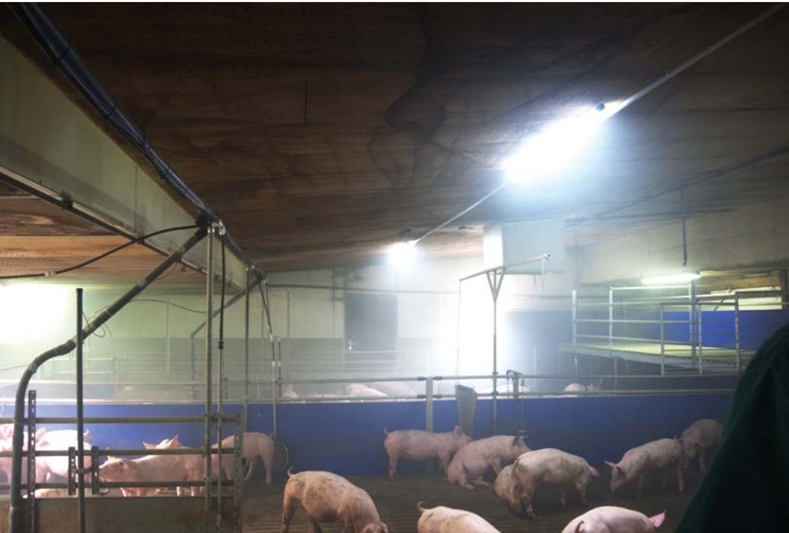
Abb. 49: Ausnebeln eines Abteils, um Fehler in der Luftführung zu überprüfen
