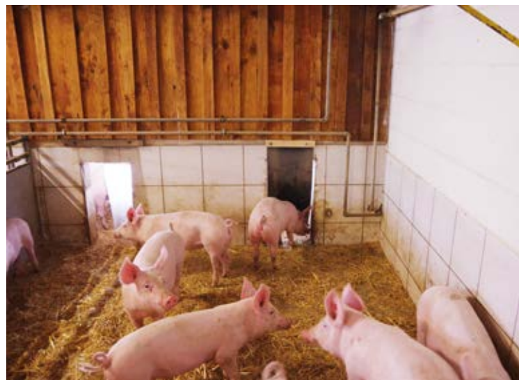
Abb. 33: Nachher – Durchbruch für einen zweiten Ausgang
