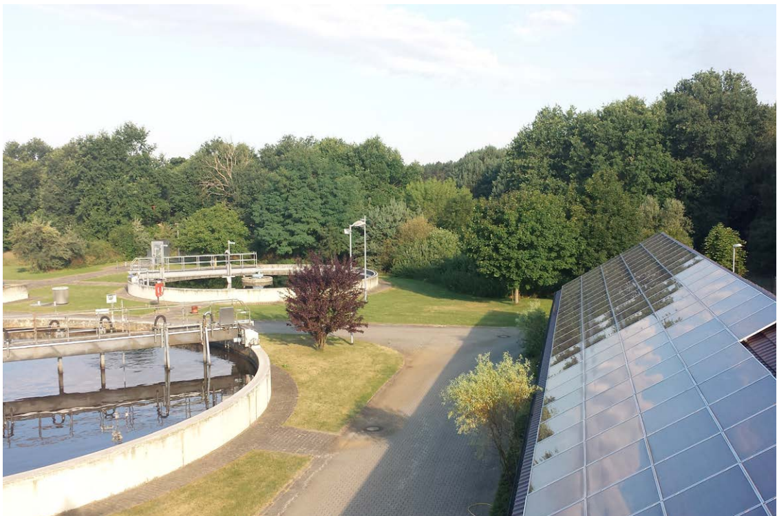
Abb. 6: Kläranlage Brück mit Belebungs- und Nachklärbecken sowie dem Betriebsgebäude mit Solaranlage (AZV Planetal)
