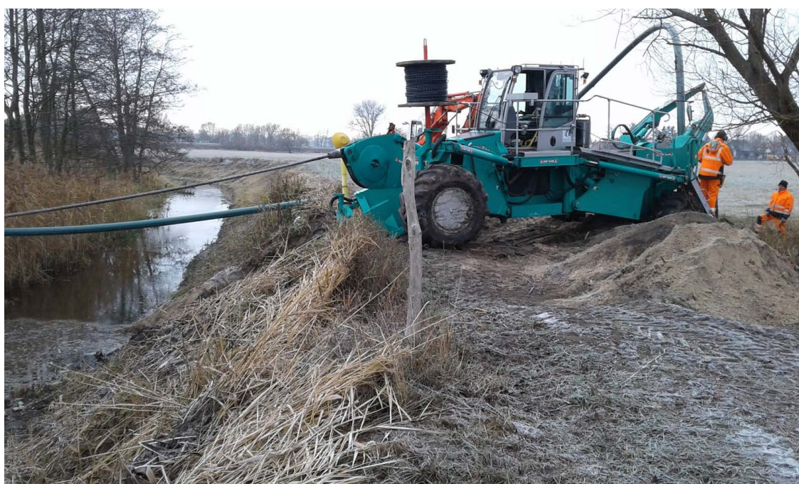
Abb. 7: Einpflügen einer Abwasserdruckleitung durch den Zweckverband Kremmen
