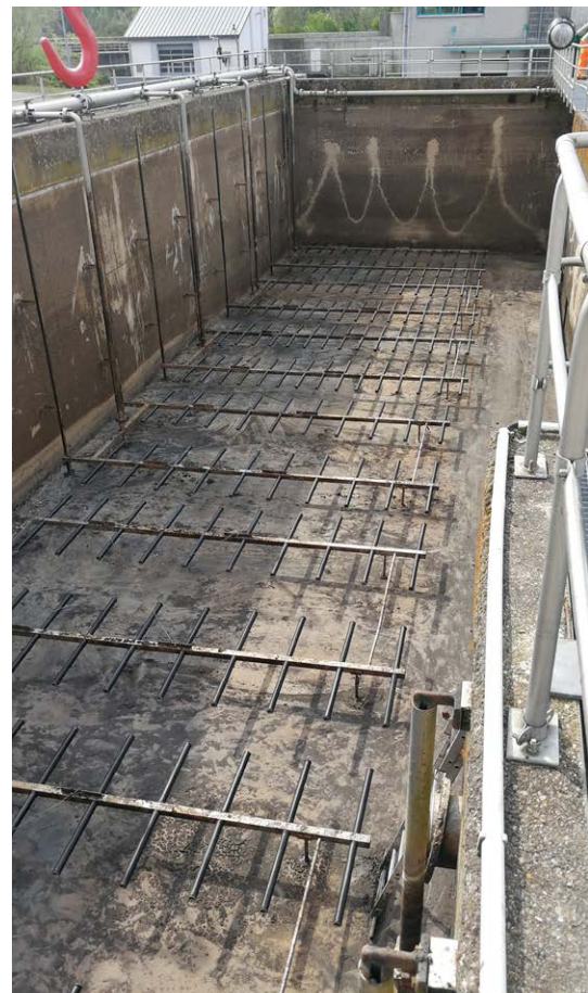
Abb.: 13: Wartungsarbeiten am Belebungsbecken auf dem Klärwerk Kremmen (ZV Kremmen)
