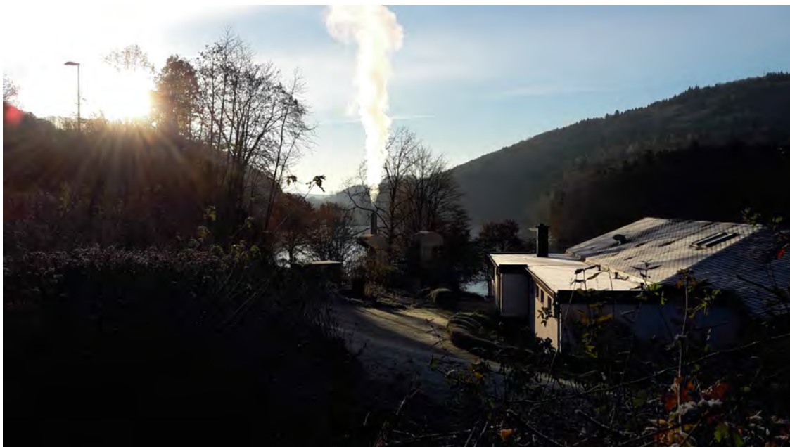
Abb. 5.2: Satelliten-BHKW zur Wärmeversorgung eines Hotelkomplexes
