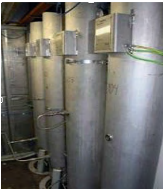
Abb. 5.3: selbstgebaute Anlage zur Aufbereitung von Biogas zu Kraftstoff
