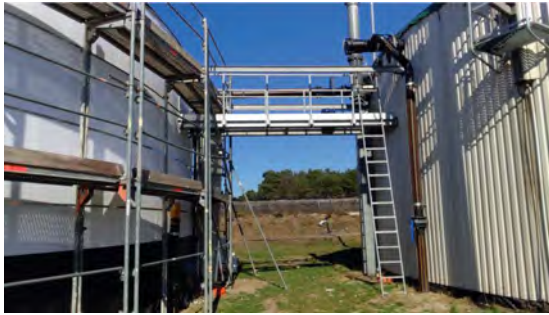
Abb. 4.6: Bauphase - Isolierung des zweiten Behälters, der Heizungseinbau und die gasdichte Einbindung in das System
