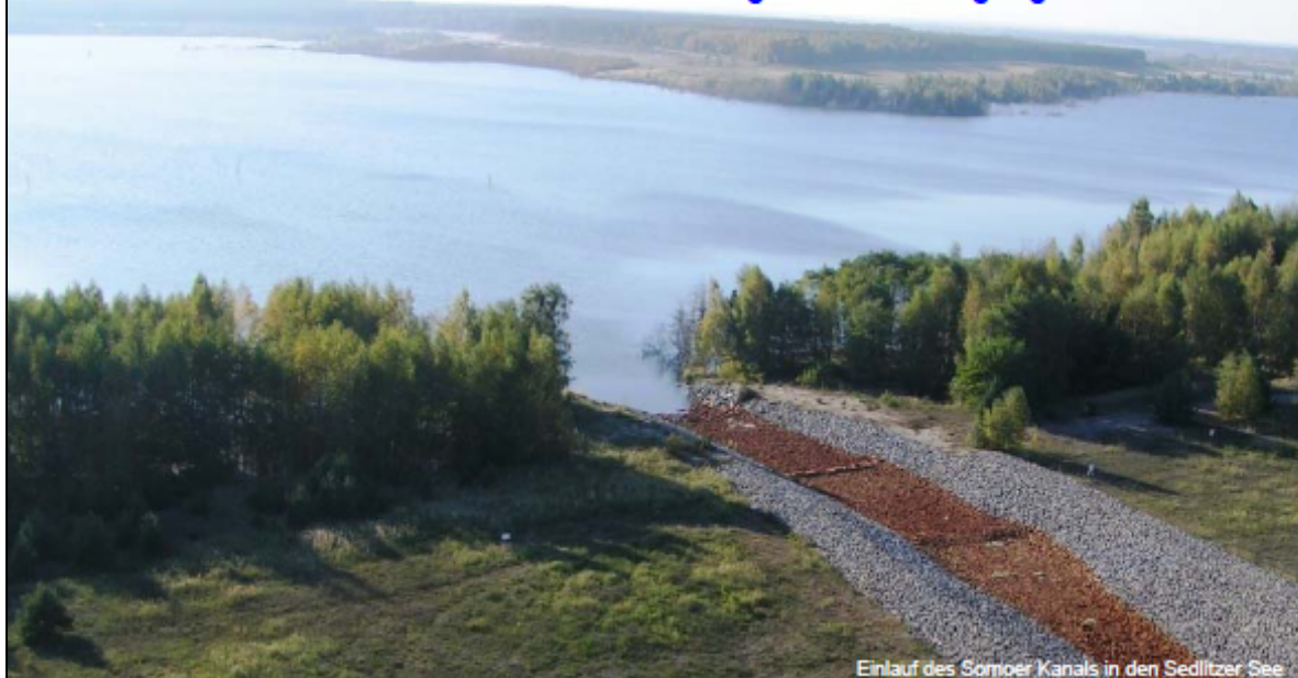
Einlauf des Sommer Kanals in den Sedlitzer See
