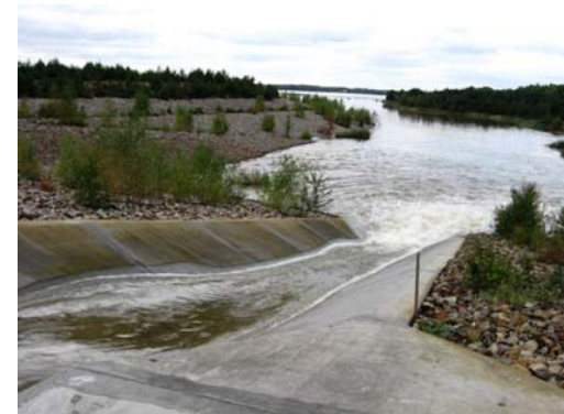
Einleitungsbauwerk in den Speicher Lohsa II
