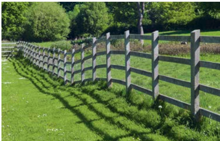
Ein Stabilzaun aus Holz mit vier Querverbindungen
