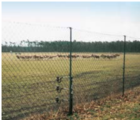
Maschendrahtzaun mit nach innen vorgesetzten Elektrodrähten.
