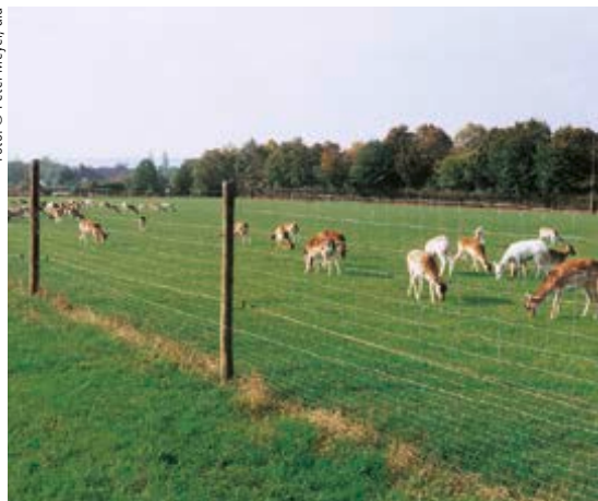
Knotengeflecht für Wildgehege mit innen vorgesetztem Elektrodraht.
