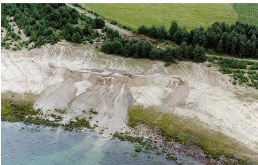
**Abb. 5:** Böschungsbruch am 08.07.2012 Speicher Lohsa
