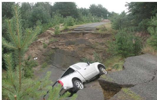
**Abb. 6:** Böschungsbruch am 08.07.2012 Speicher Lohsa
