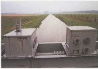
Kanalisiertes Fließ mit Wehr
