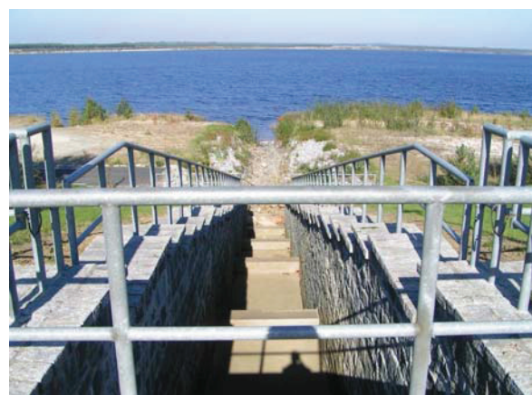
Abb. 3-4: Zulaufanlage von der Schwarzen Elster zum Neuwieser See (Fotos: Schümberg 2010)
