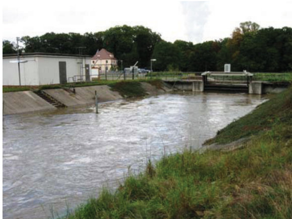
Abb. 4-3: Ausleitbauwerk aus der Spree am Wehr Bärwalde (links) und Einlaufbauwerk (Schussrinne mit Tosbecken) in das Speicherbecken Lohsa II (rechts) (Fotos: Gassert 2010)
