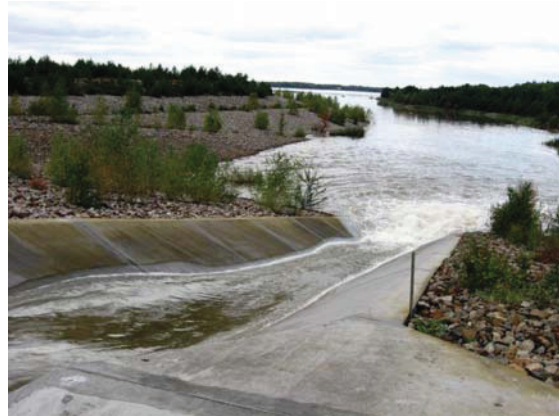
Abb. 4-3: Ausleitbauwerk aus der Spree am Wehr Bärwalde (links) und Einlaufbauwerk (Schussrinne mit Tosbecken) in das Speicherbecken Lohsa II (rechts) (Fotos: Gassert 2010)
